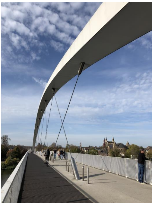
Pont pour les vélos et piétons
